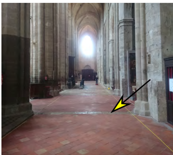
Figure 2: Vue de l'aile Nord en direction de l'Ouest. La flèche jaune pointe le dallage de marbre/calcaire qui apparaît fortement sur les cartes GPR de la figure 1. À l'arrière plan, on voit l'entrée de la crypte et Albanes Saintenoy prospectant avec le radar de sol. Crédit photo E.L.
